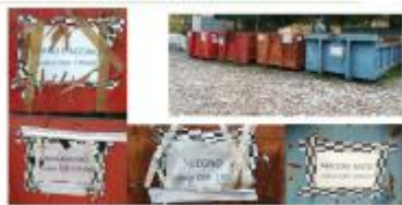
Fase 2 - Riciclo e smaltimento dei rifiuti in cantiere
