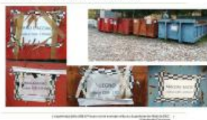
Fase 2 - Riutilizzo e smaltimento dei rifiuti in cantiere
