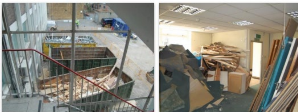
Figura 21. La demolizione selettiva delle costruzioni.
