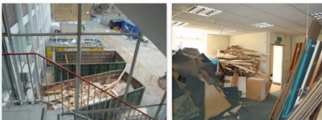
Figura 21. La demolizione selettiva delle costruzioni.
