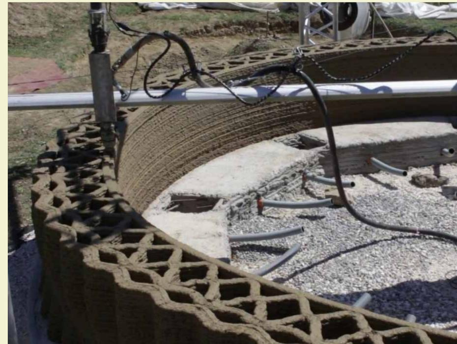
Il brevetto *RH4003D* è un premiscelato a base di argilla naturale proveniente dalle risaie, in combinazione con lolla e paglia di riso, specificamente progettato per i processi di stampa 3D additiva.
